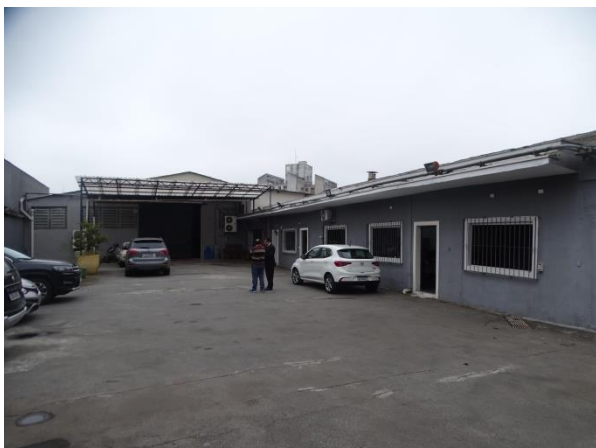
Foto 1 - Vista geral do imóvel.
