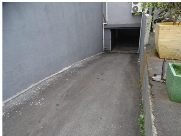
Foto 16 - Vista da rampa de acesso ao subsolo do galpão.
