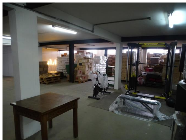
Foto 18 - Vista do subsolo do galpão.
