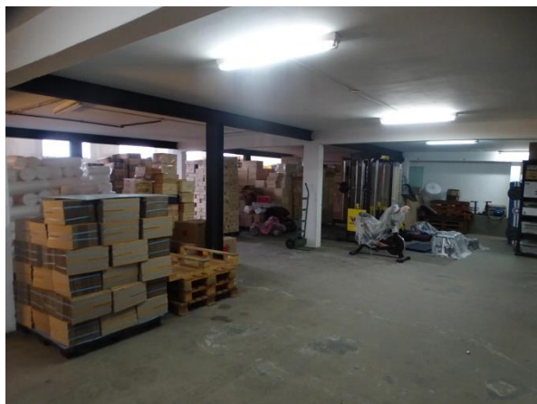
Foto 19 - Vista do subsolo do galpão.
