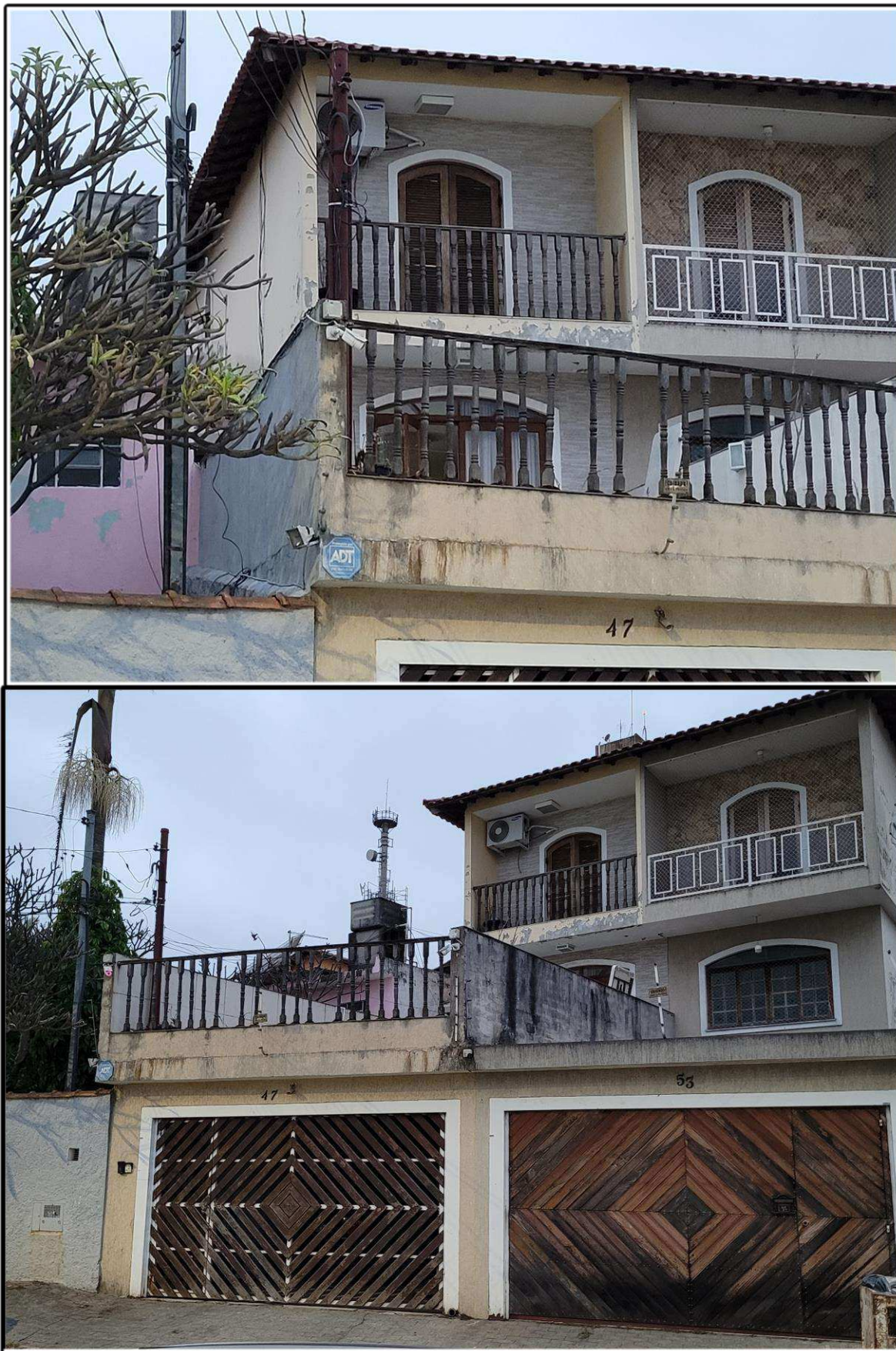
Foto 15 - Detalhes da fachada do imóvel.
