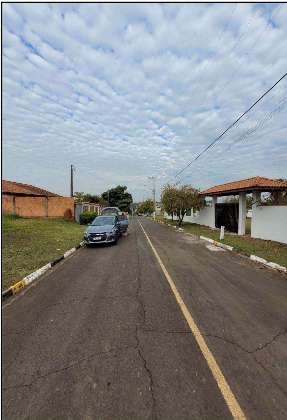
Foto 4 - Outra vista geral da Rua Francisco Rozendo de Camargo, Quadra D, Lote 01.
