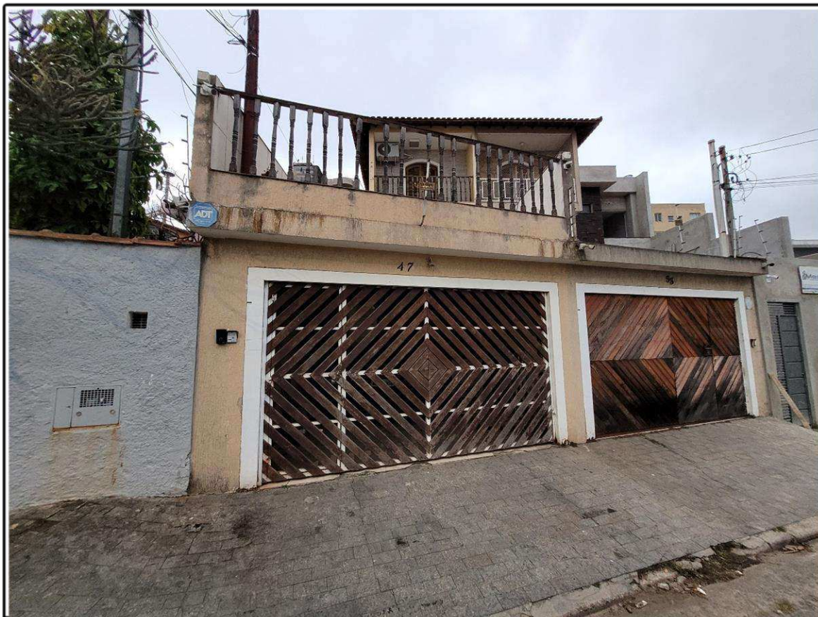
Fotos 12 e 13 - Vistas da fachada frontal do imóvel objeto da ação.
