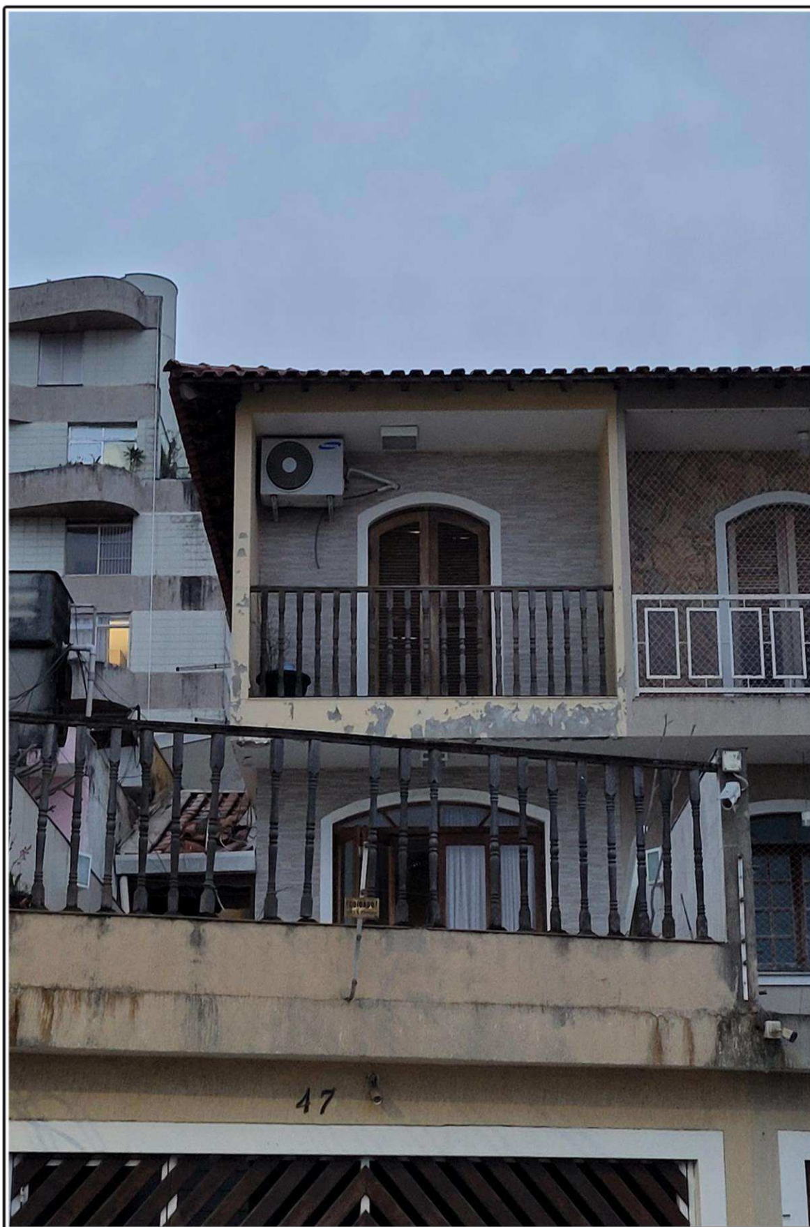
Foto 14 - Detalhe da fachada do imóvel.
